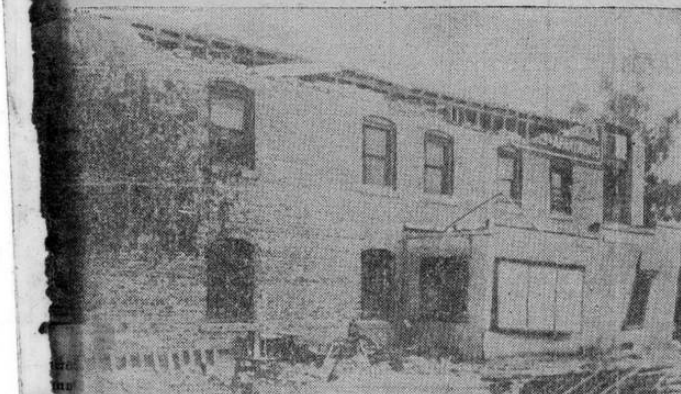
Fotografía, tomada en Brawley, California, muestra los efectos de los recientes temblores en el Valle Imperial. Este edificio perteneció al sistema nacional de Brawley.
